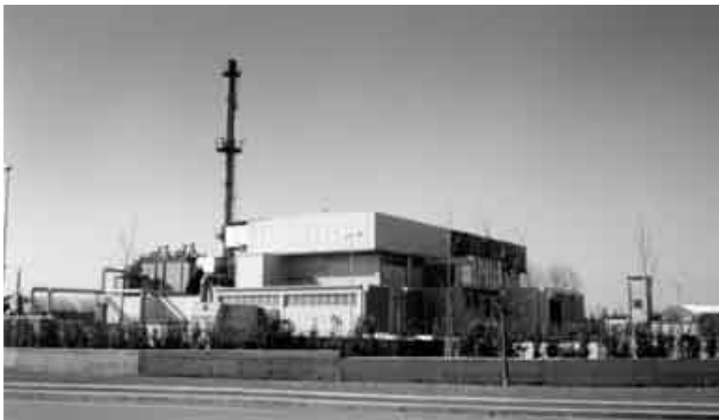
L'impianto di Montale
